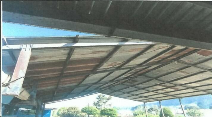
Foto1: Vista del techo de la cancha y salon de usos multiples
